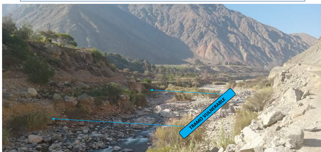
FOTOGRAFIA 02: Tramo crítico en la Margen derecha del río San Juan se ejecutara limpieza, descolmatacion, conformacion de dique y enrocado en una longitud de 1,650 m.
